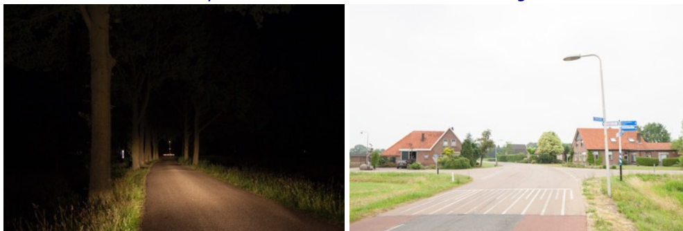
Foto: Links schrikhek waardoor t-splitsing goed zichtbaar is. Rechts lichter kleur wegdek bij kruising, reflecteert in het donker waardoor het dan ook goed zichtbaar is.
