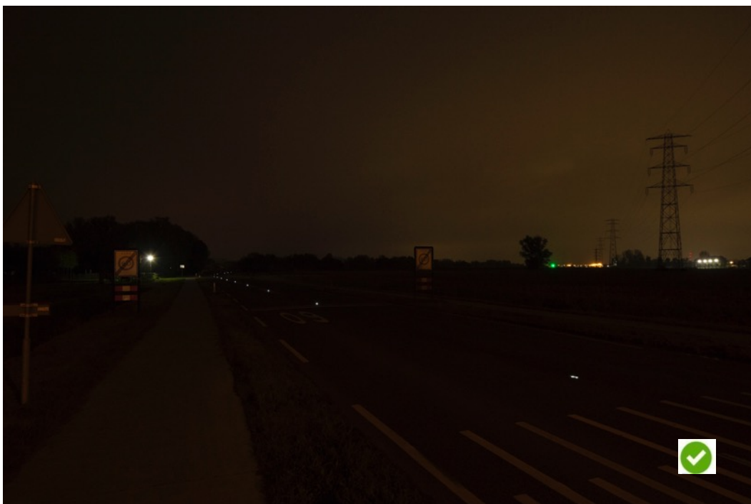
Foto: Ledlampjes in de as van de weg, waardoor het verloop van de weg goed te zien is.
