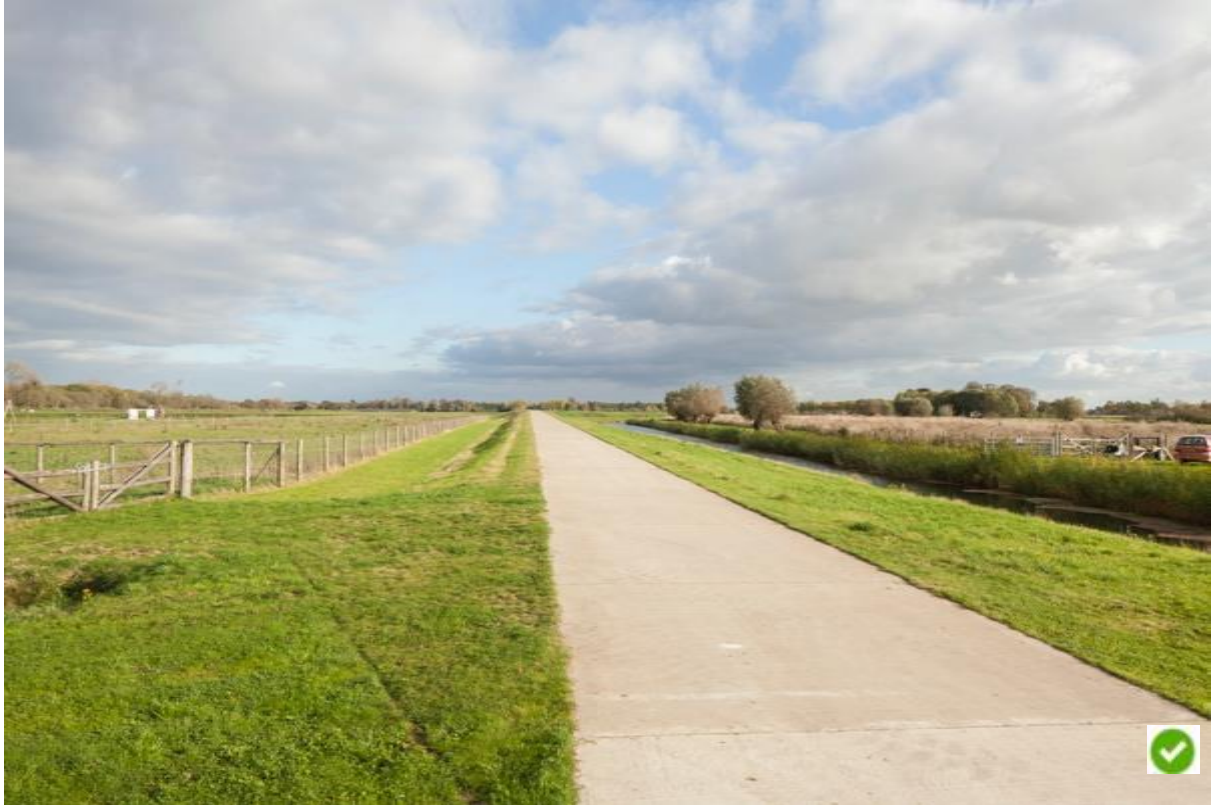
Foto: fietspad door park Lingezege. Geen verlichting.
