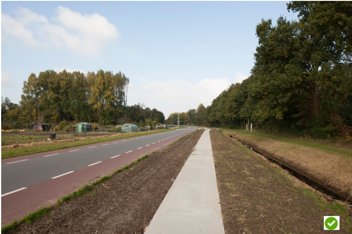
Foto: Een voorbeeld van een lichtkleur fietspad. Het losliggende pad is van beton en daarmee lichter van kleur (zolang het wegdek droog is). Het fietspad op de weg is roodgekleurd om een goed contrast te krijgen. Je kan dit wegdek ook in het donker laten reflecteren door een toeslagmateriaal erdoor te doen.
