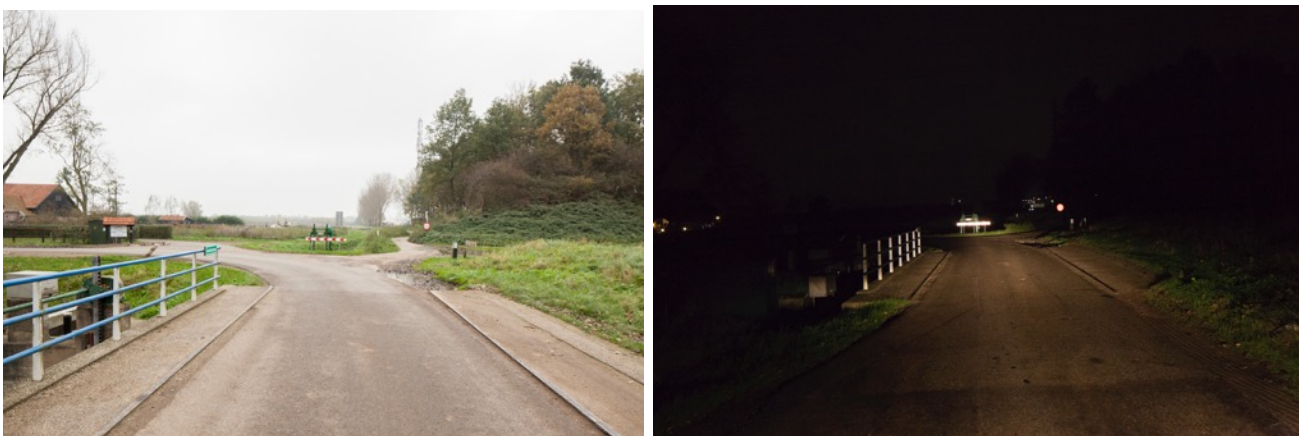
Foto: Lingestraat in Elst, schrikhek waardoor de bocht zonder een lantaarnpaal goed zichtbaar is van ver.
