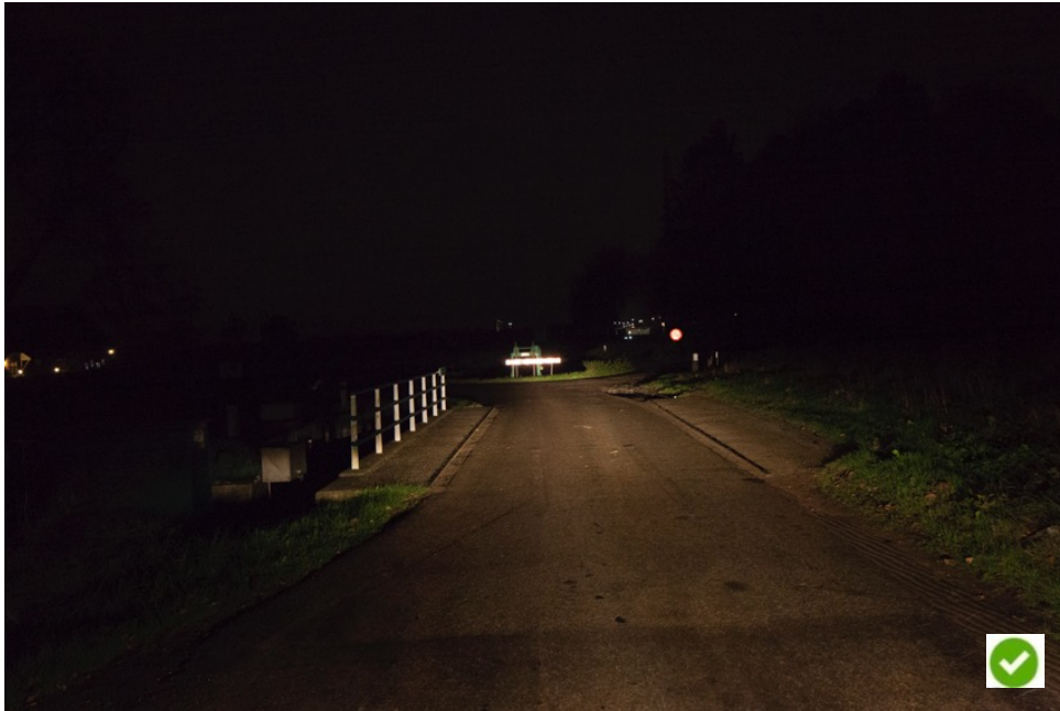
Foto: Lingestraat in Elst, een voorbeeld van een schrikhek zonder lantaarnpaal. De bocht is goed zichtbaar zonder een lantaarnpaal.
