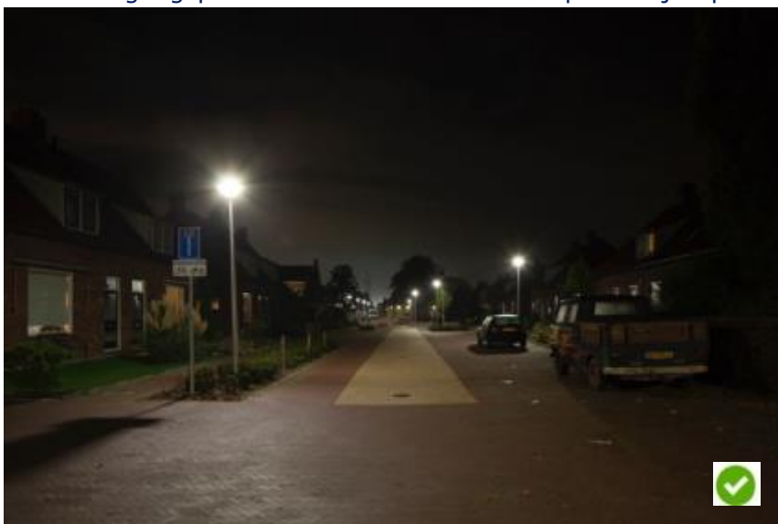
Foto: Fazantstraat in Driel. Het licht is gelijkmatig over de weg verdeeld zodat er geen zwarte vlekken zijn.
