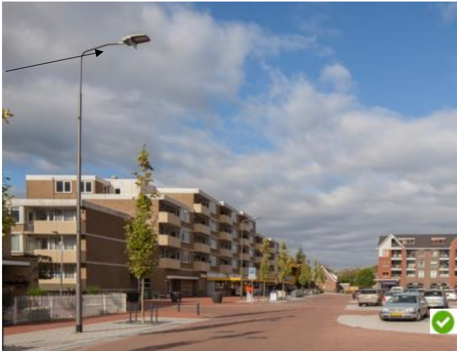
Foto: Europlein in Elst waar de lamp door middel van een kap wordt afgeschermd zodat het licht niet de woningen in schijnt.
